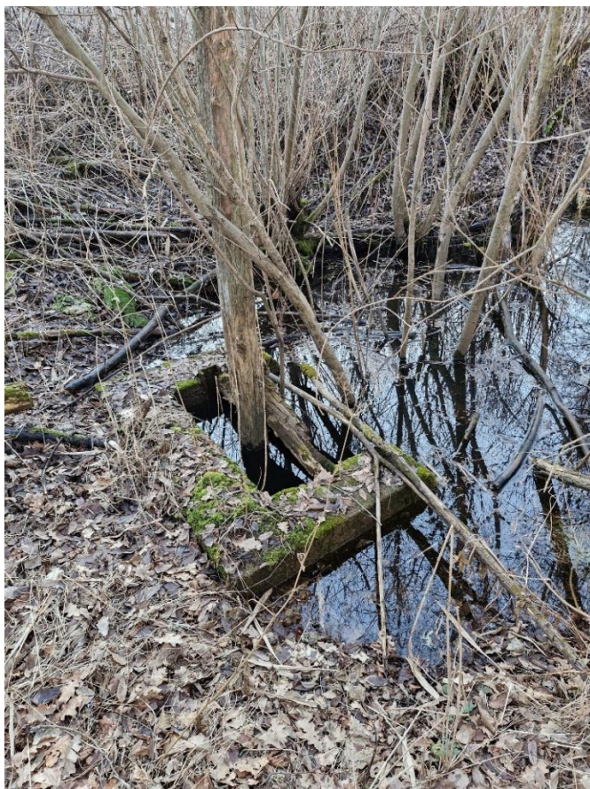
Figur 21. Pumpanordningens inlopp från diket.
