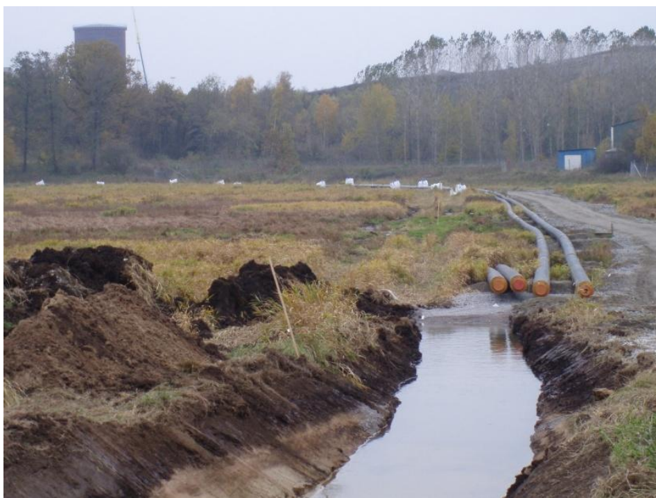
Figur 11 Bild från anläggningen av fjärrvärmeledningen, fotograferad mot väst (bild erhållen från Affärsverken, tagen 2011-10-26).
