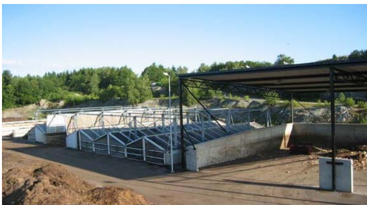
Komposteringsanläggningen vid Bubbetorp
